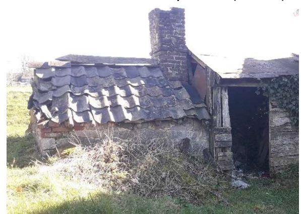
Photo 4 : Le bâtiment « mystère » (arrière)
